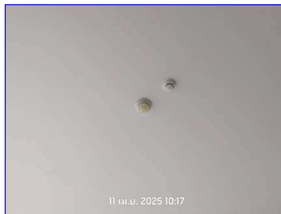
รูปที่ 2.25 อุปกรณ์ตรวจจับควัน
