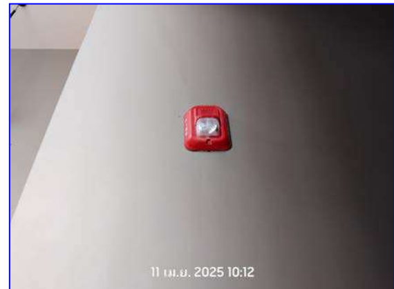
รูปที่ 2.24 อุปกรณ์ส่งสัญญาณแจ้งเหตุเพลิงไหม้
