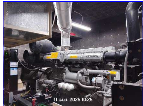
รูปที่ 2.11 เครื่องกำเนิดไฟฟ้า
