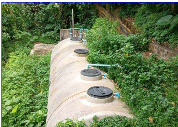
รูปที่ 2.12 ระบบบำบัดน้ำเสีย
