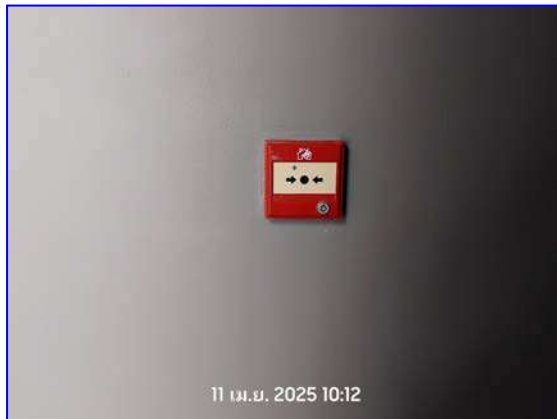
รูปที่ 2.24 อุปกรณ์ส่งสัญญาณแจ้งเหตุเพลิงไหม้
